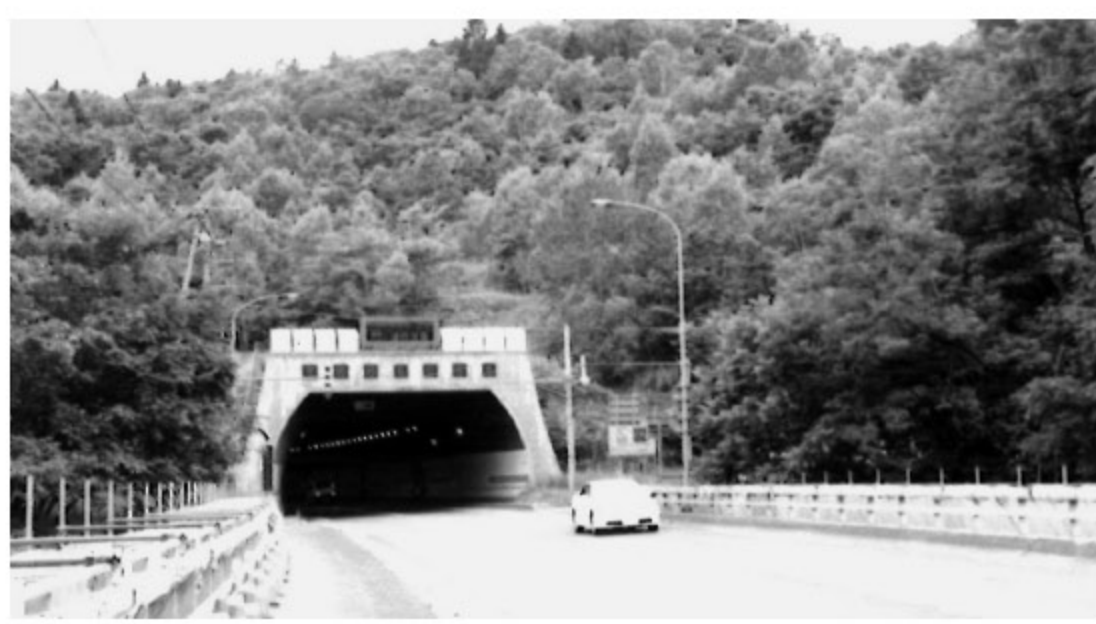
①春志内トンネル―旭川側口
